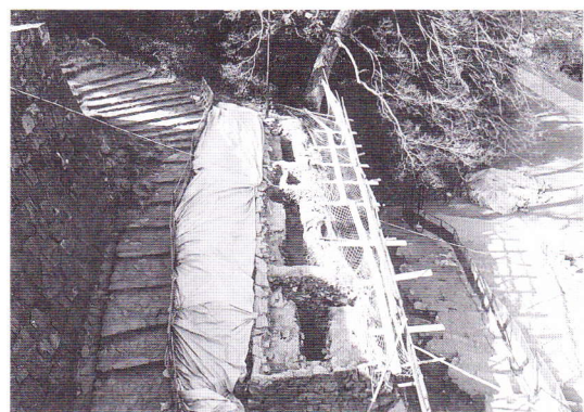
石垣上面調査区（南から）
