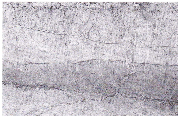
C区南東壁土層断面の噴砂・砂派貫入状況
