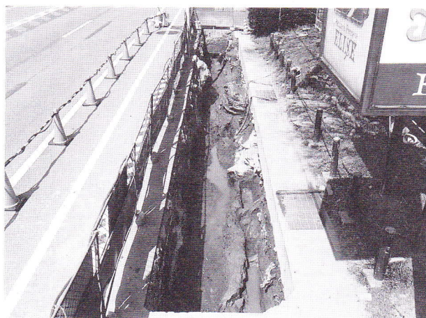
調査地全景(南から)
