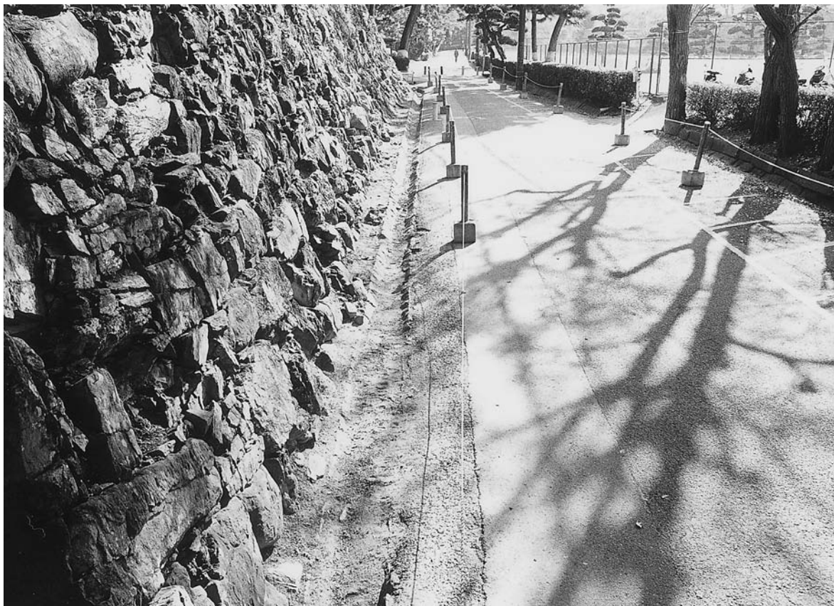
第3区 調査前の状況（北から）
