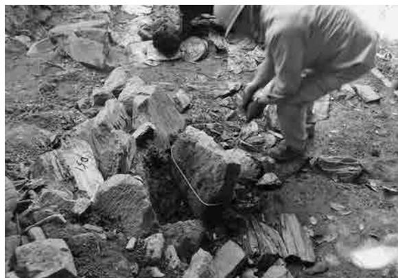
石垣D14 被災前崩落箇所 取外し状況
