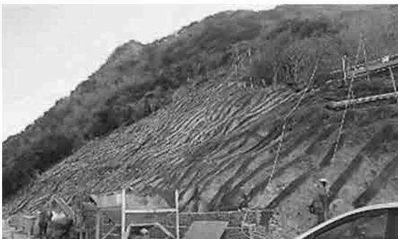
第84図 ジオファイバー工法（排水材設置）
