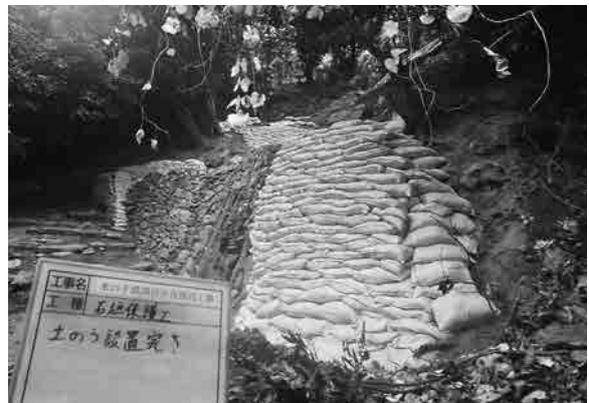
石垣保護工 (D14西端) 土のう設置完了
