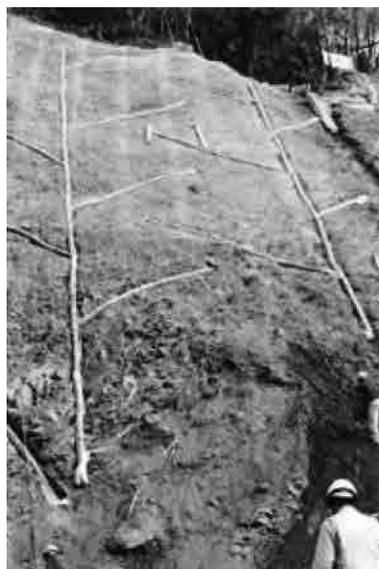
第81図 地下水排水溝 施工例
