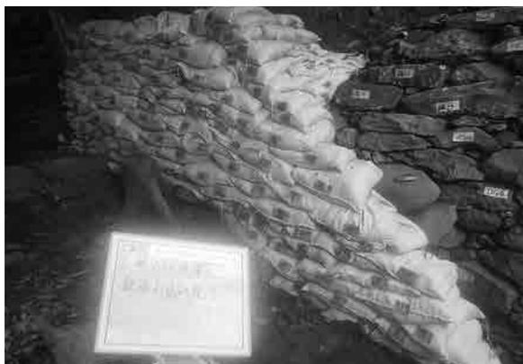
石垣保護工 鉄筋打込み完了
