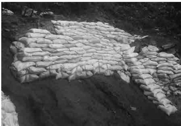
石垣保護工（斜面上部）土のう設置完了
