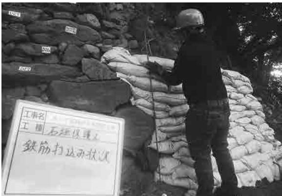
石垣保護工 (D14西端) 鉄筋打込み状況
