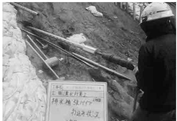
湧水対策工 排水補強パイプ2段目
