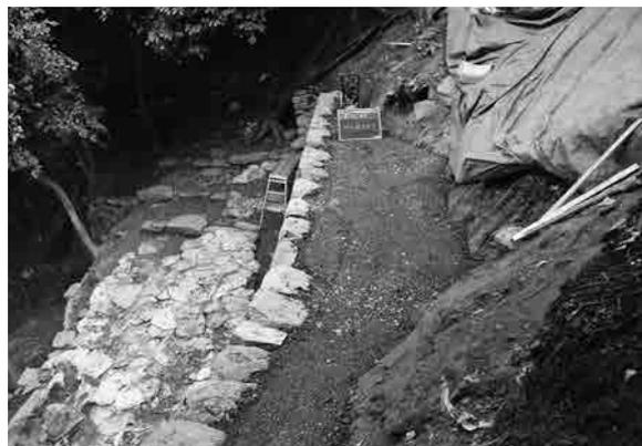
石垣D14石積工 基礎碎石転圧完了
