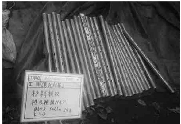
湧水対策工 排水用補強パイプ
