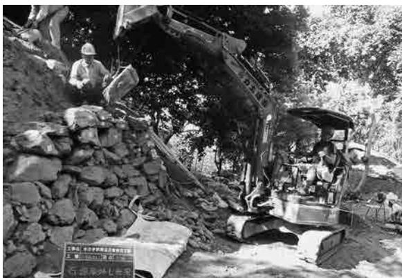
石垣D14取外し工 石垣取外し状況1
