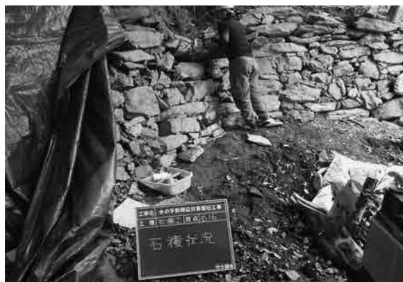
石垣D16被災前崩落箇所 石積状況
