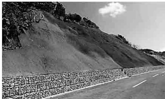
第85図 ジオファイバー工法（施工直後）
