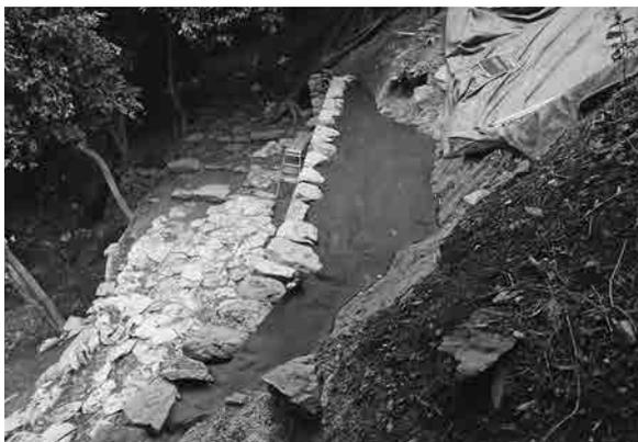
石垣D14石積工 吸出し防止材敷設完了
