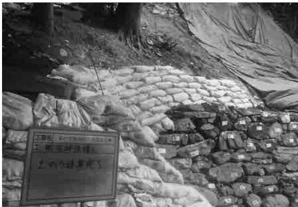
石垣保護工（D14東端）土のう設置完了
