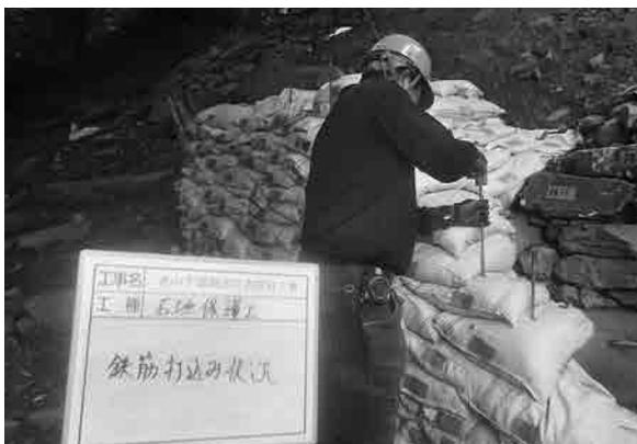
石垣保護工（東端）鉄筋打込み状況
