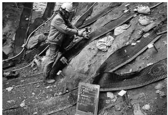
連続繊維補強土工 裏面排水アンカーピン打込み状況
