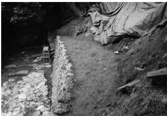
石垣D14石積工 仮置土転圧完了
