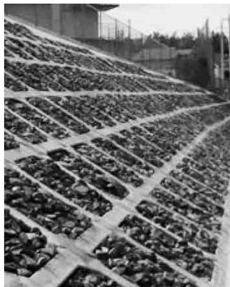
第82図 ごり石を用いたのり砕 施工例
