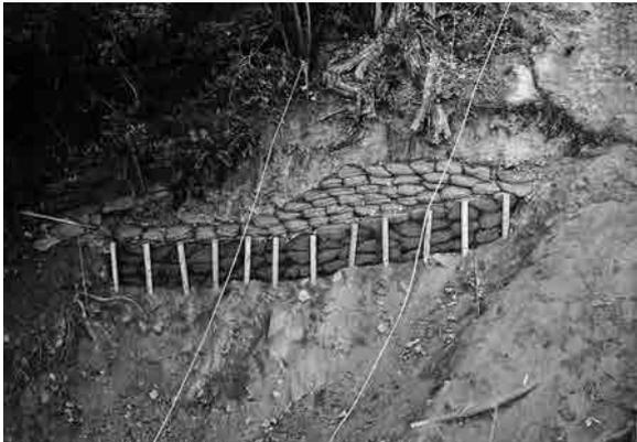
透水性土のう設置完了
