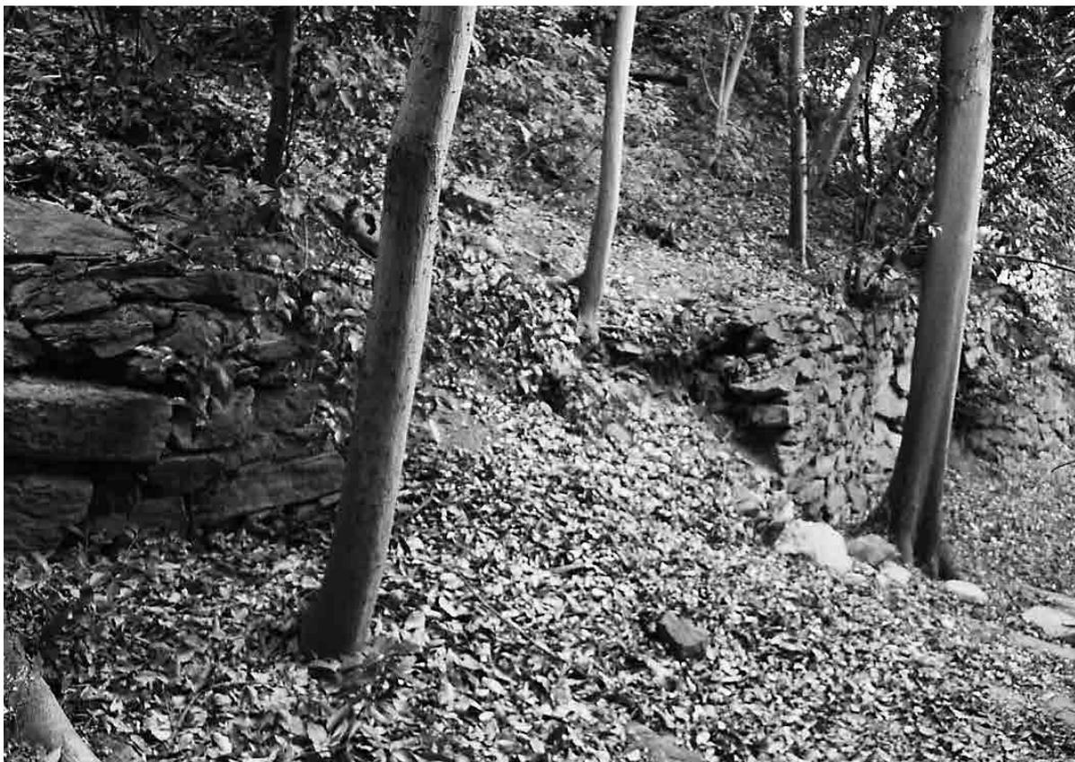
被災前から一部が崩落していた石垣D14（石垣カルテ作成のため平成24年に撮影）
