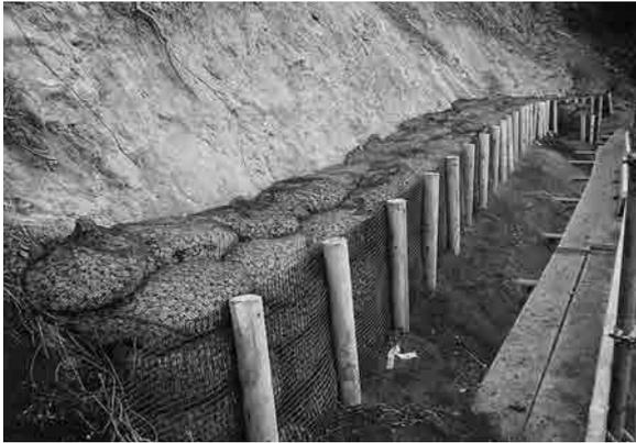
透水性土のう設置完了
