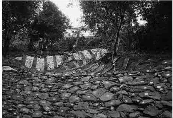
連続繊維補強土工 裏面排水設置完了1
