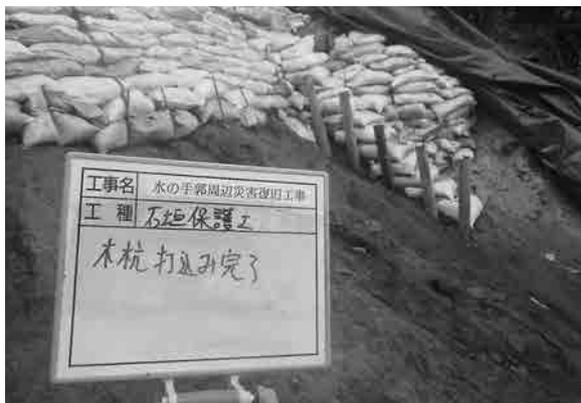
石垣保護工（斜面上部）木杭打込み完了
