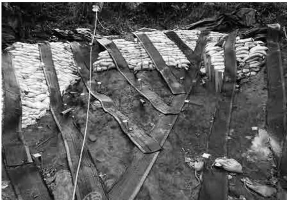
連続繊維補強土工 裏面排水設置完了2
