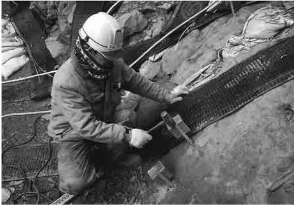
連続繊維補強土工 プレート付きアンカー打込み状況
