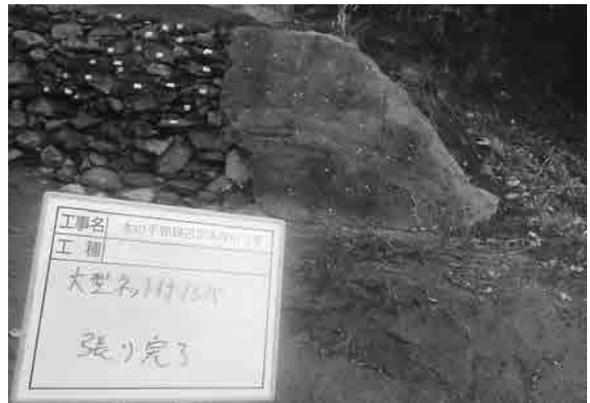
ネット付き大型ノシバ工 大型ネット付きノシバ張り完了2
