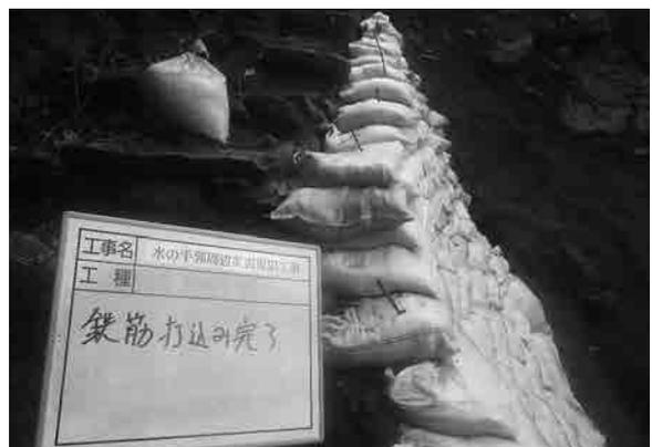
通路復旧工 鉄筋打込み完了
