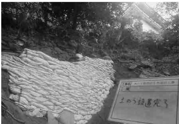
通路復旧工 土のう設置完了
