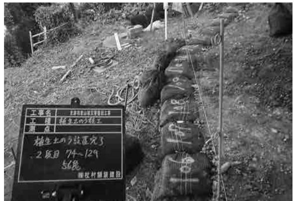
植生土のう設置完了2段目
