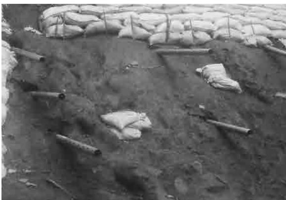
排水補強パイプ 打込み完了
